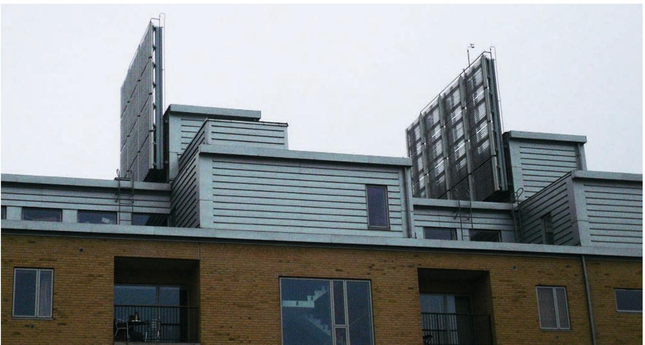
Abb. 123: Solarthermie auf den Dächern der Gebäude <sup>78</sup>
