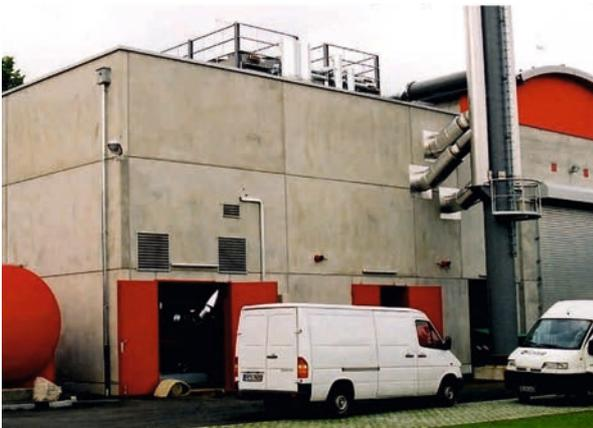
Abb. 129: Blockheizkraftwerk mit Holzhackschnittelfeuerung <sup>87</sup>
