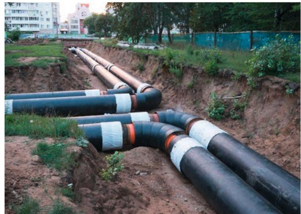
Abb. 143: Beispielhafte Darstellung der Installation von Fernwärme-Leitungen<sup>107</sup>
